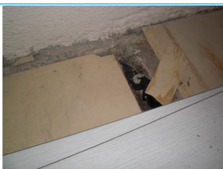
Matériaux : ZPSO-S15 Prélèvement : P025; P034 Description : Dalle de sol 30*30 crème et colle noire Localisation : RdC - 039b; RdC - 023; RdC - 027; RdC - 029; RdC - 024 Résultat : Présence d'amiante Quantité : 64
