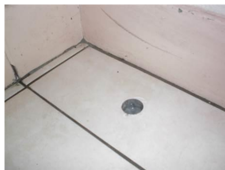
Matériaux : ZPSO-S03 Prélèvement : P003 Description : Colle de carrelage 30*30 crème sur restes suspectés de colle noire Localisation : RdC - 015 Résultat : Absence d'amiante Quantité : ml
