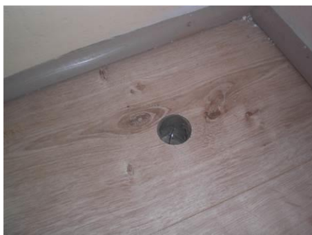
Matériaux : ZPSO-S05 Prélèvement : P004 Description : Colle noire sous ragréage et stratifié Localisation : RdC - 011; RdC - 007; RdC - 008; RdC - 012 Résultat : Présence d'amiante Quantité : 63
