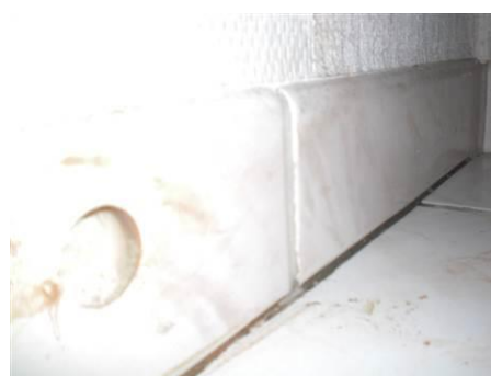
Matériaux : ZPSO-P01 Prélèvement : P082 Description : Colle de plinthes 5*30 Localisation : RdC - 015 Résultat : Absence d'amiante Quantité :
