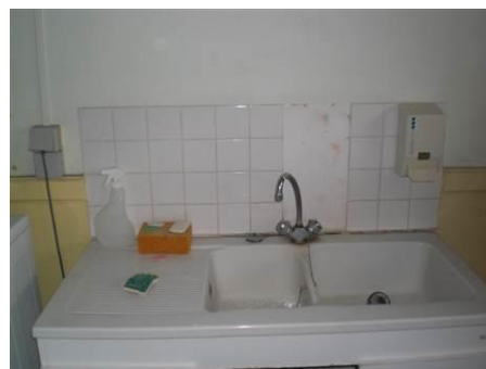
Matériaux : ZPSO-F10 Prélèvement : P031 Description : Colle de faïence 10*10 blanche Localisation : RdC - 028 Résultat : Présence d'amiante Quantité : 0,5
