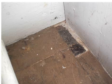
Matériaux : ZPSO-S01 Prélèvement : P001 Description : Dalle de sol marron 22*22 et colle noire Localisation : RdC - 038; RdC - 042 Résultat : Présence d'amiante Quantité : 6ml
