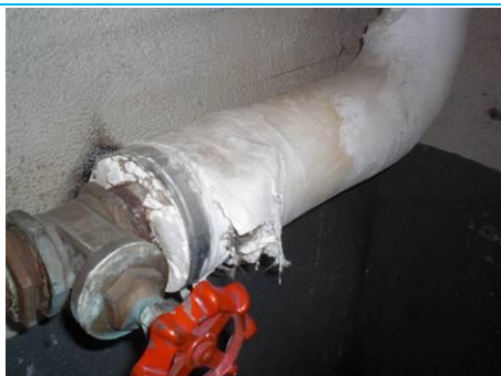
Matériaux : ZPSO-D01 Prélèvement : P097; P098 Description : Enveloppe et calorifuge plâtré Localisation : RdC - 002 Résultat : Absence d'amiante Quantité : m2
