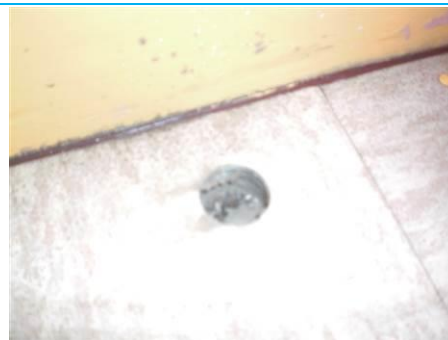
Matériaux : ZPSO-S02 Prélèvement : P002; P039 Description : Dalle de sol verte, colle noire et ragréage sous sol souple Localisation : RdC - 037; RdC - 039; RdC - 040; R1 - 029 Résultat : Présence d'amiante Quantité : 60ml
