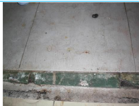
Matériaux : ZPSO-S19 Prélèvement : P033 Description : Dalle de sol 22*22 verte et colle noire (amiantées) sous dalle de sol 30*30 blanche et colle jaune (non amiantées) Localisation : RdC - 029 Résultat : Présence d'amiante Quantité : 1
