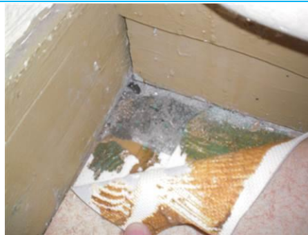
Matériaux : ZPSO-S08 Prélèvement : P012; P009 Description : Dalle de sol verte, colle noire et ragréage sous dalle souple 30*30 Localisation : RdC - 036; RdC - 036b Résultat : Présence d'amiante Quantité : 4
