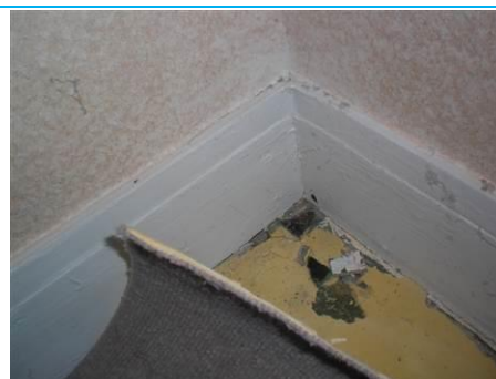
Matériaux : ZPSO-S14 Prélèvement : P024 Description : Dalle de sol 22*22 verte et colle noire sous moquette Localisation : RdC - 022 Résultat : Présence d'amiante Quantité : 17
