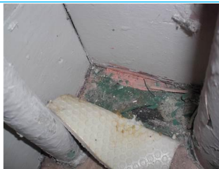
Matériaux : ZPSO-S02 Prélèvement : P002; P039 Description : Dalle de sol verte, colle noire et ragréage sous sol souple Localisation : RdC - 037; RdC - 039; RdC - 040; R1 - 029 Résultat : Présence d'amiante Quantité : 60
