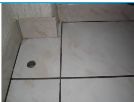
Matériaux : ZPSO-S04 Prélèvement : P081 Description : Colle noire sous carrelage 30*30 blanc et sol souple Localisation : RdC - 015 Résultat : Présence d'amiante Quantité : 4
