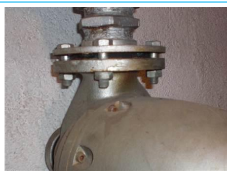
Matériaux : ZPSO-D02 Prélèvement : P099 Description : Joint de bride pompe obus Localisation : RdC - 002 Résultat : Absence d'amiante Quantité : m2
